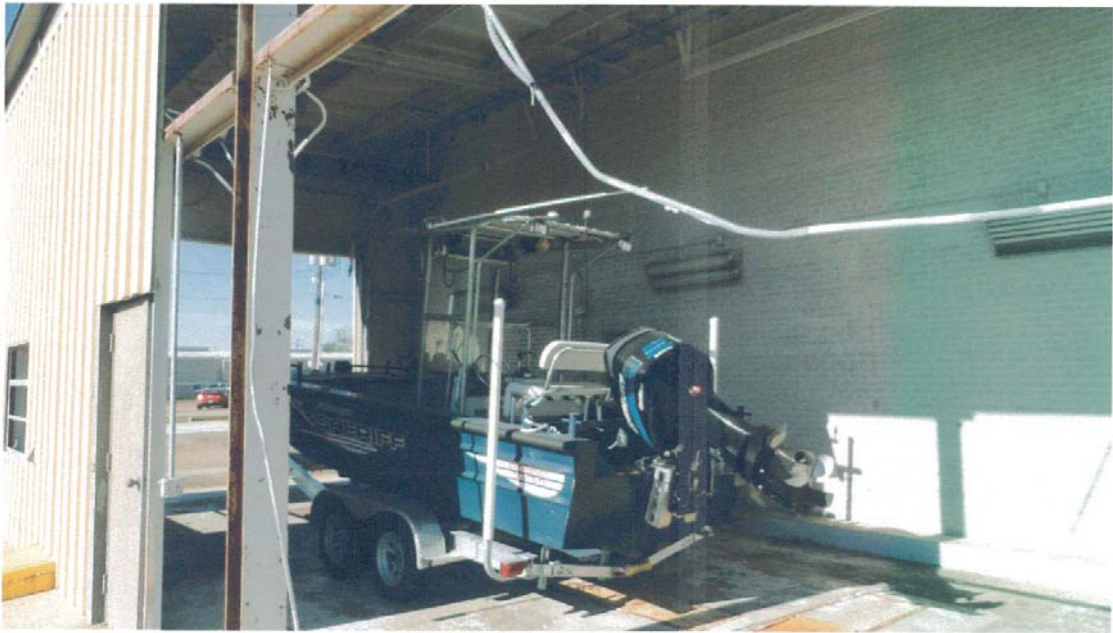
INTERIOR (WASH BAY)
